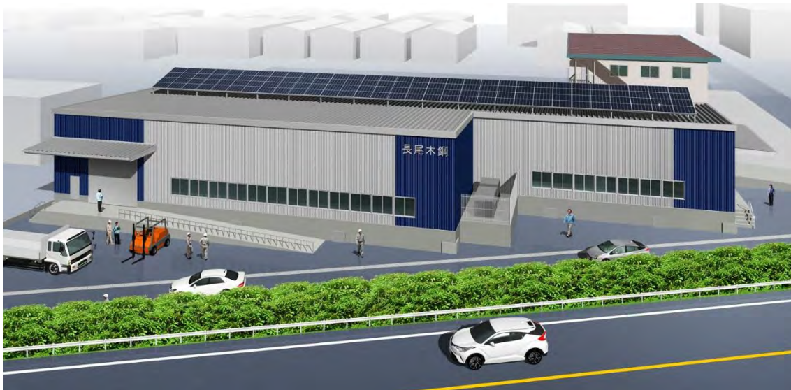
※現在建設中の新工場イメージ画像
